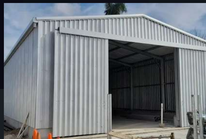
DOS AGUAS STEEL FRAMING
